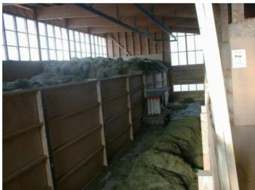
*Esempio: caricando uno strato di 2 m di foraggio al 60% di SS, bisogna fare evaporare 8'400 litri d'acqua e ci vogliono da 9 a 18 giorni a seconda della meteo*
